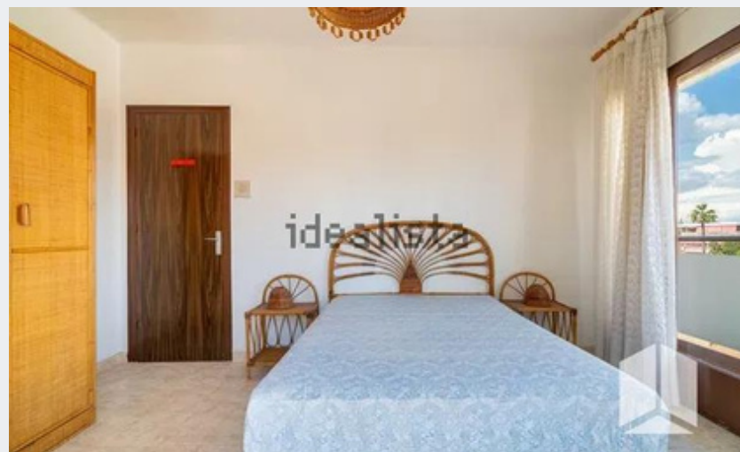
ANTES - HABITACION Derribos para ganar amplitud en balconera.
