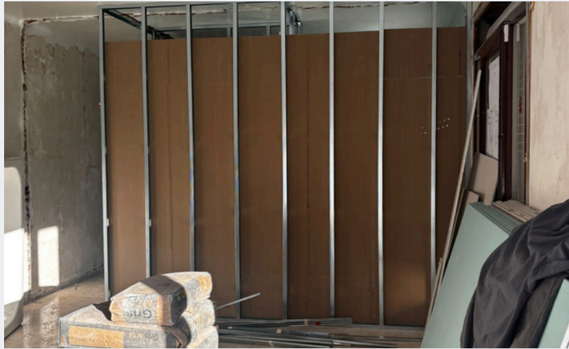
DURANTE - PARED PLADUR COCINA
